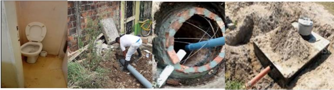
Excusado conectado a pozo ciego
